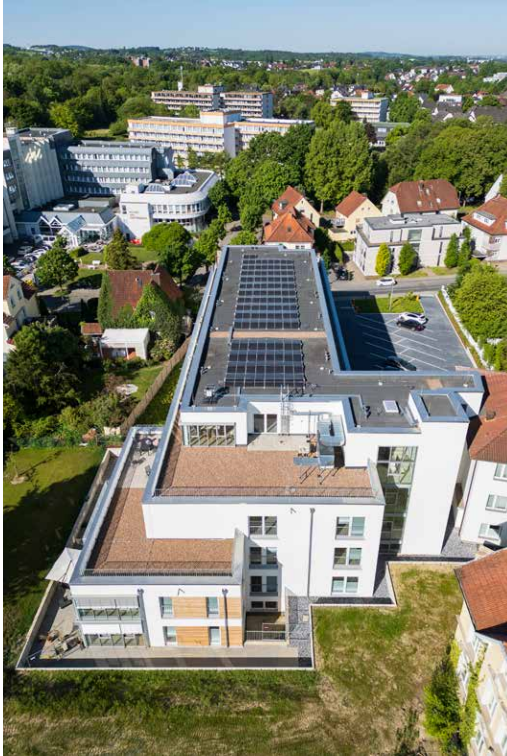
Auf aktuelle und absehbare Bedürfnisse ausgerichtet: der Teilneubau in Bad Oeynhausen. Im Sinne der Nachhaltigkeit wurde auf dem Dach eine Photovoltaikanlage installiert. Foto: KD-Bank/Andreas Buck
